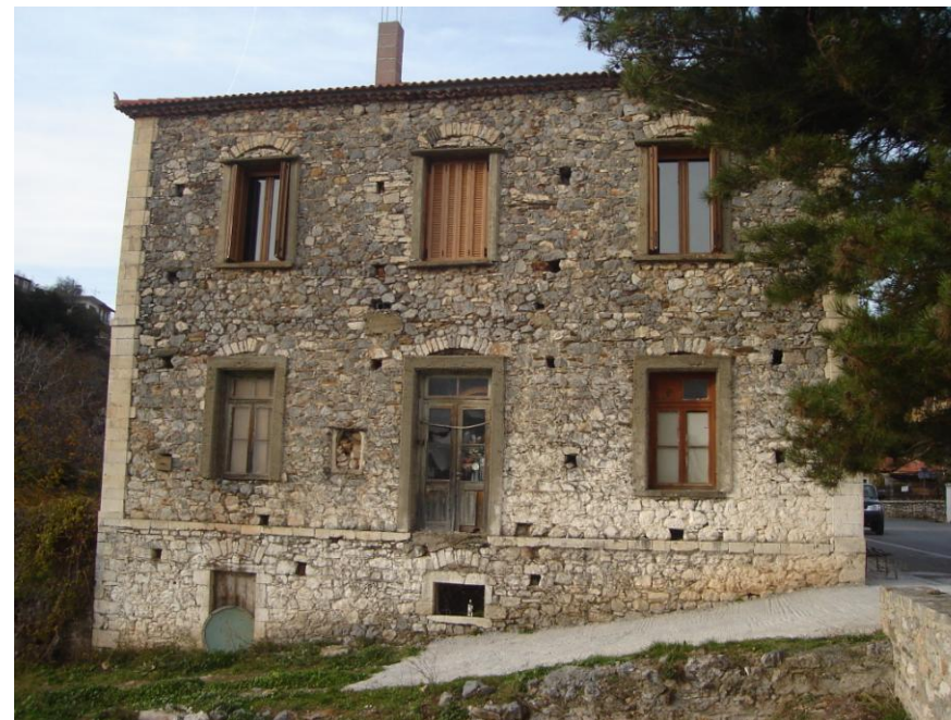
Τοποθέτηση πλαισίων από σκυρόδεμα στα ανοίγματα.
