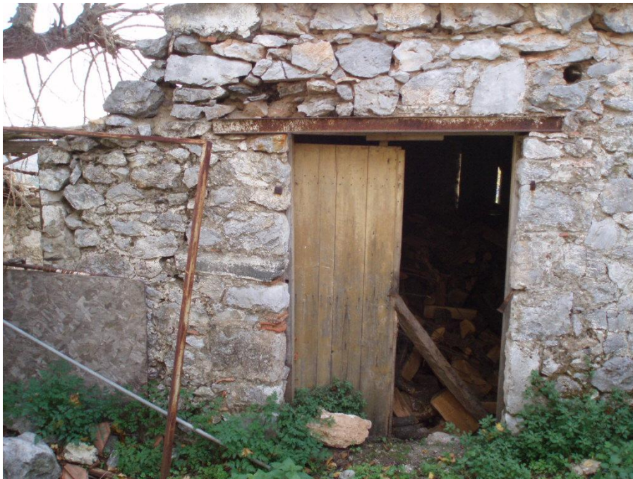
Αντικατάσταση ξύλινου πρεκιού με μεταλλικό.
