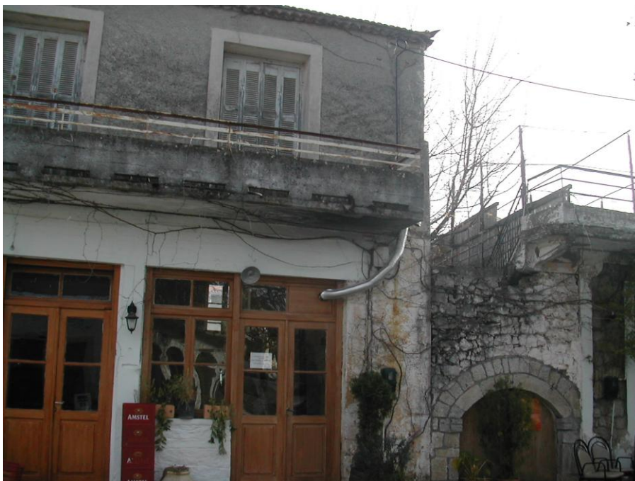
Προσθήκη ορόφου και μπαλκονιού από οπλισμένο σκυρόδεμα και αντικατάσταση των ξύλινων κουφωμάτων με αλουμινένια.
