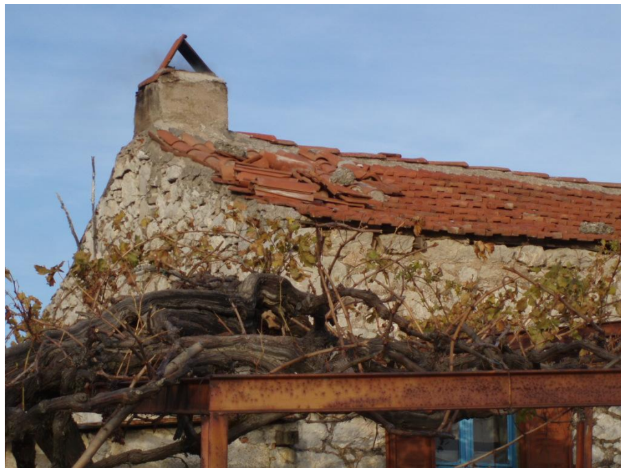
Καμινάδα από σκυρόδεμα και μεταλλική πέργκολα
