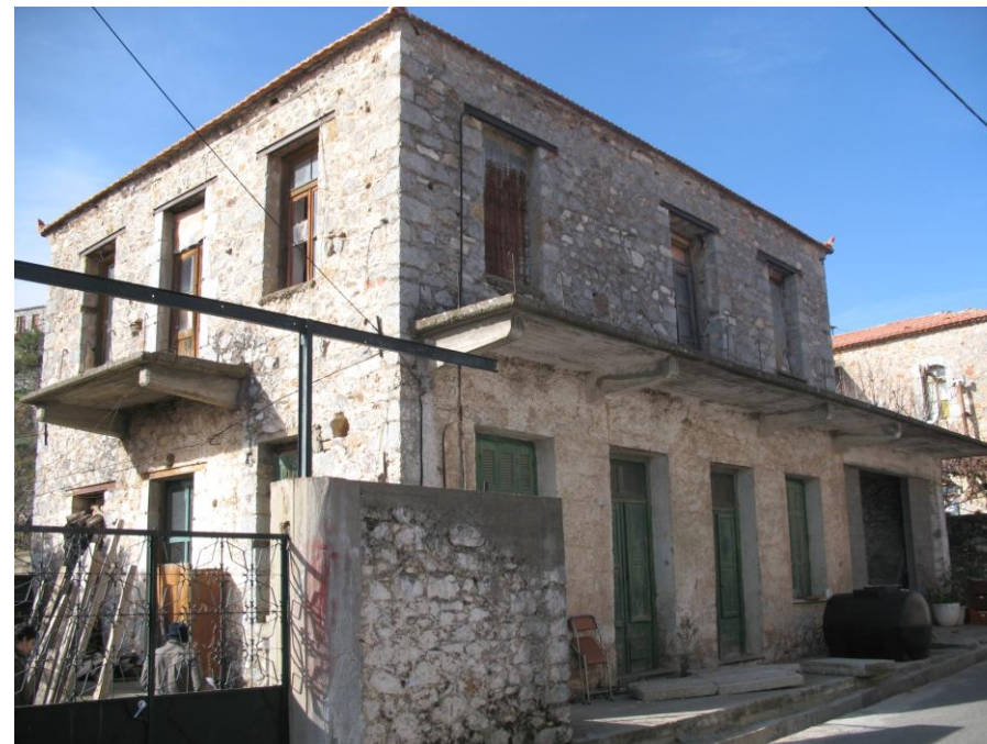
Αντικατάσταση πρεκιών με μπετονένια , τοποθέτηση πλάκας από οπλισμένο σκυρόδεμα στους εξώστες , εφαρμογή κονιάματος στο ισόγειο και τοποθέτηση μεταλλικής αυλόπορτας.
