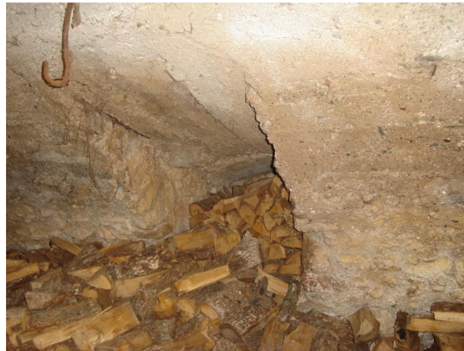
Εφαρμογή κονιάματος στην κοίλη μεριά του θόλου.
