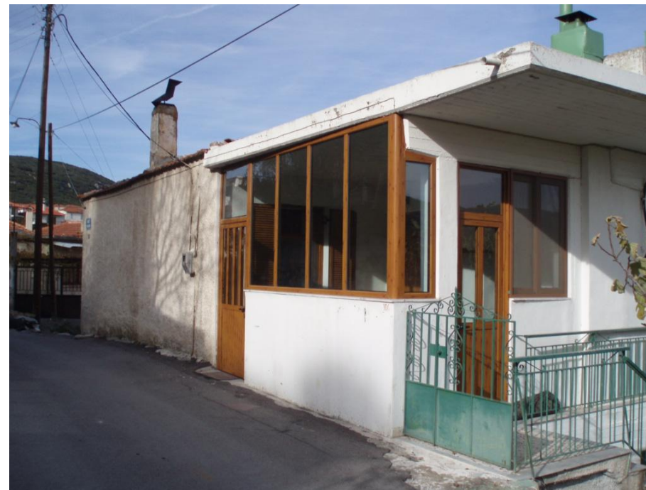
Προσθήκη σε παλιό κτίσμα, μπετονένιας κατασκευής με αλουμινένια ανοίγματα
