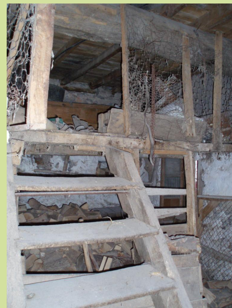
Ξύλινη εσωτερική σκάλα.
