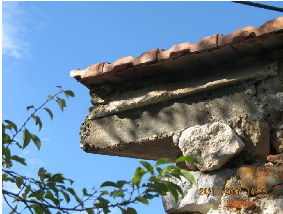
Επέμβαση από σκυρόδεμα στη νέα στέγη με γαλλικά κεραμίδια
