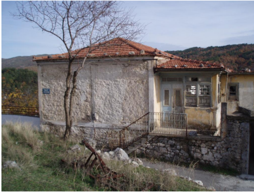
Αντικατάσταση στέγης με νεώτερα υλικά κατασκευής.
