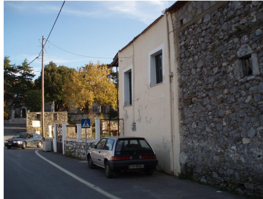
Υπερύψωση του κτηρίου με διαφορετικά υλικά από εκείνα του κτηρίου δεξιά.
