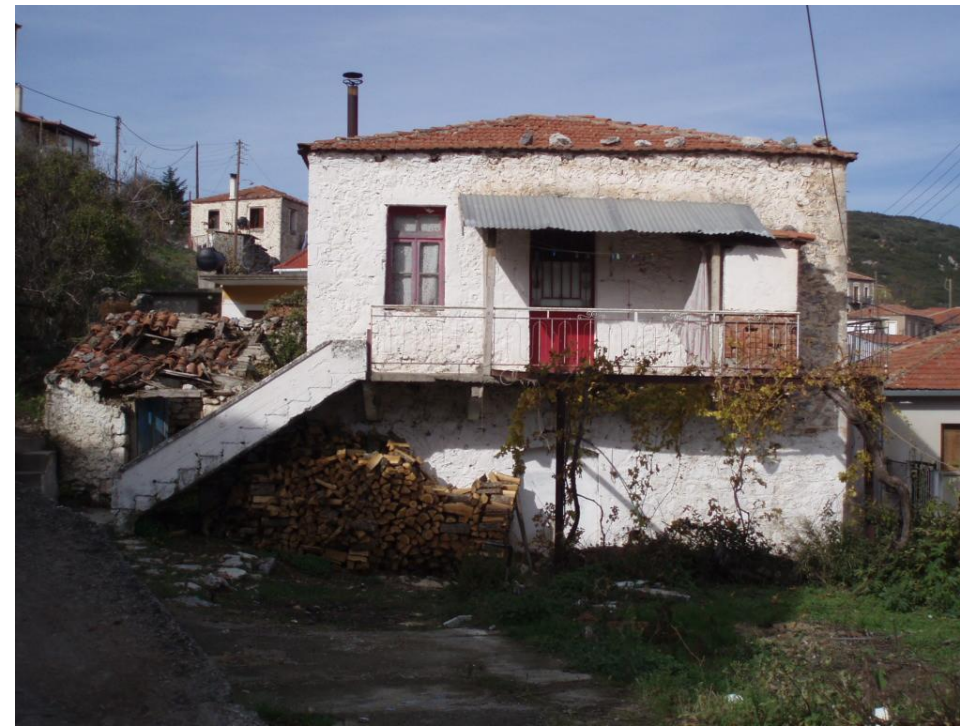
Στέγη με γαλλικά κεραμίδια, μεταλλική καπνοδόχος, τσιγκινη επιστέγαση στο επισκευασμένο χαγιάτι από οπλισμένο σκυρόδεμα
