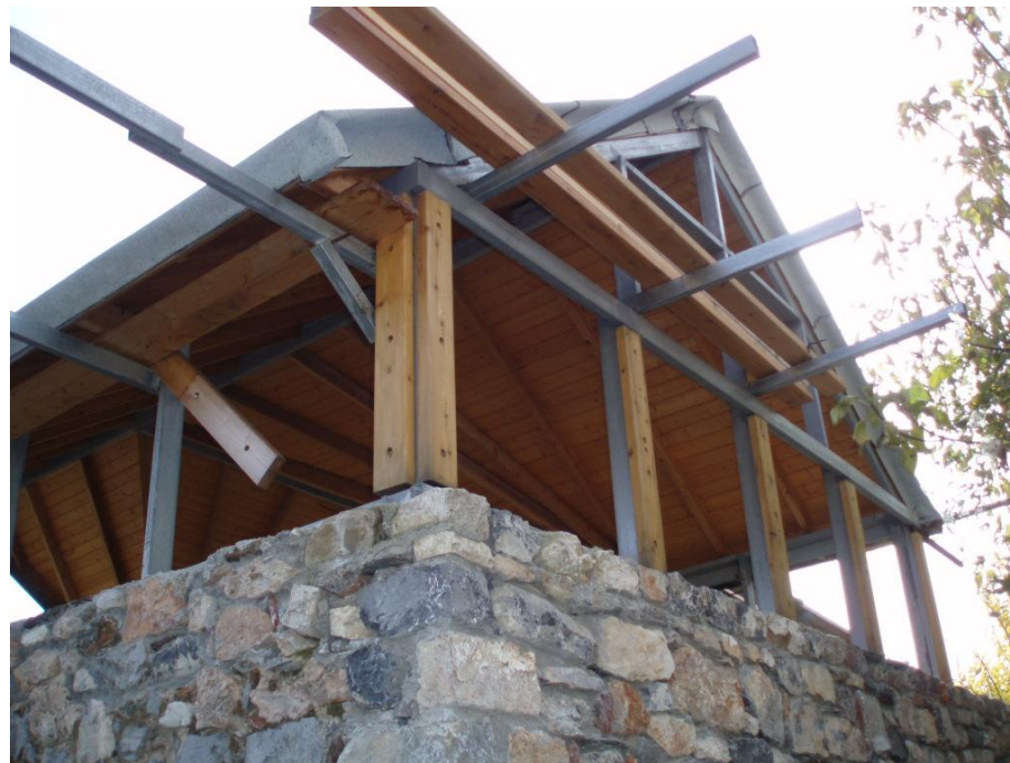
Προσθήκη στεγάστρου με σύγχρονες μεθόδους για την επίτευξη μεγαλύτερου ύψους της κατασκευής
